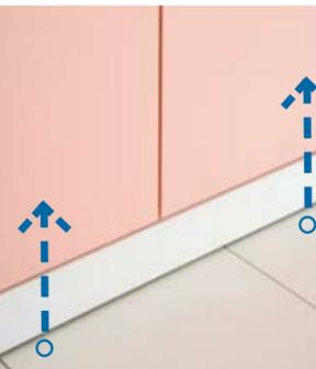
**PIEDINI LIVELLATORI:** tutti gli armadi montano di serie dei piedini livellatori che permettono la regolazione dell'armadio anche in presenza di pavimenti fuori piano.
