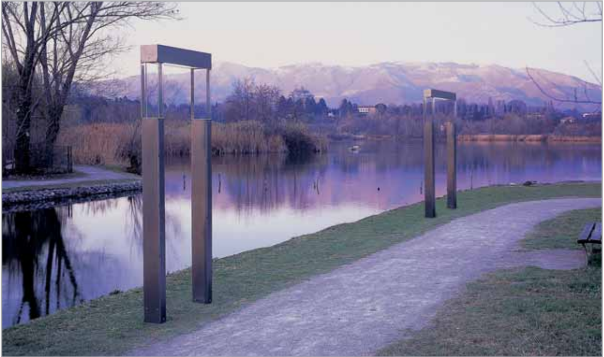
Installazione di una serie di apparecchi cod. 7.236.16.60 su una pista ciclabile. Vista diurna
